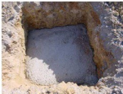
betonový podklad
