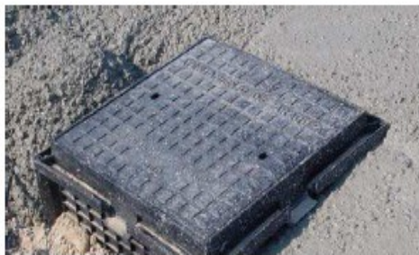
umístění a zakrytí víka tradičním způsobem
