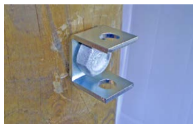
Fixation par boulon 14 mm Secured with a 14 mm bolt
